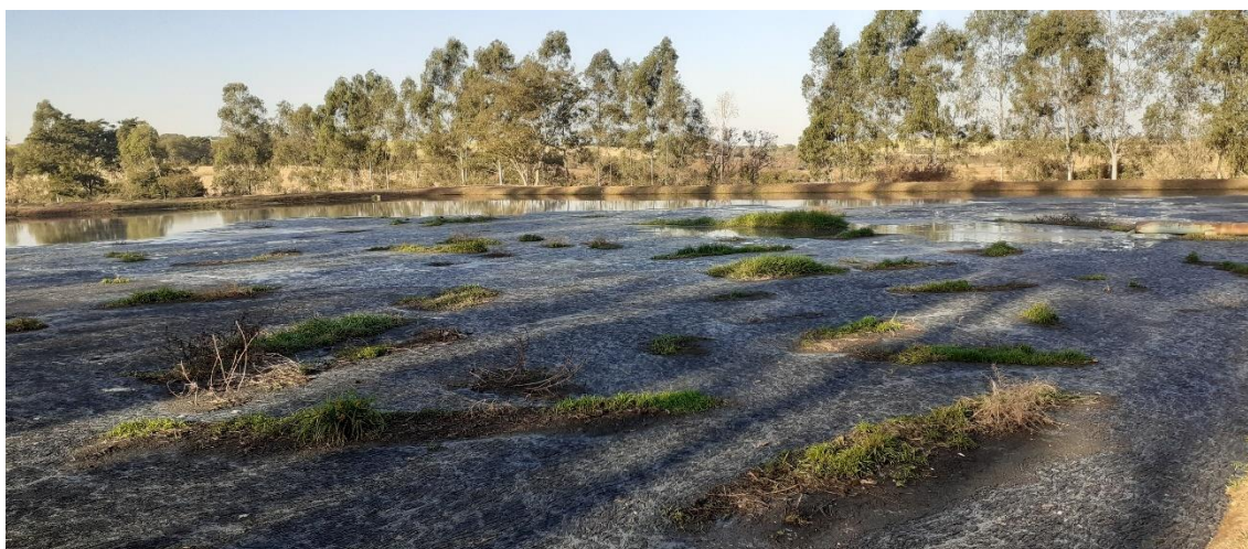
Figura 9-1. Aspectos da lagoa anaeróbia da ETE Pirangi.
