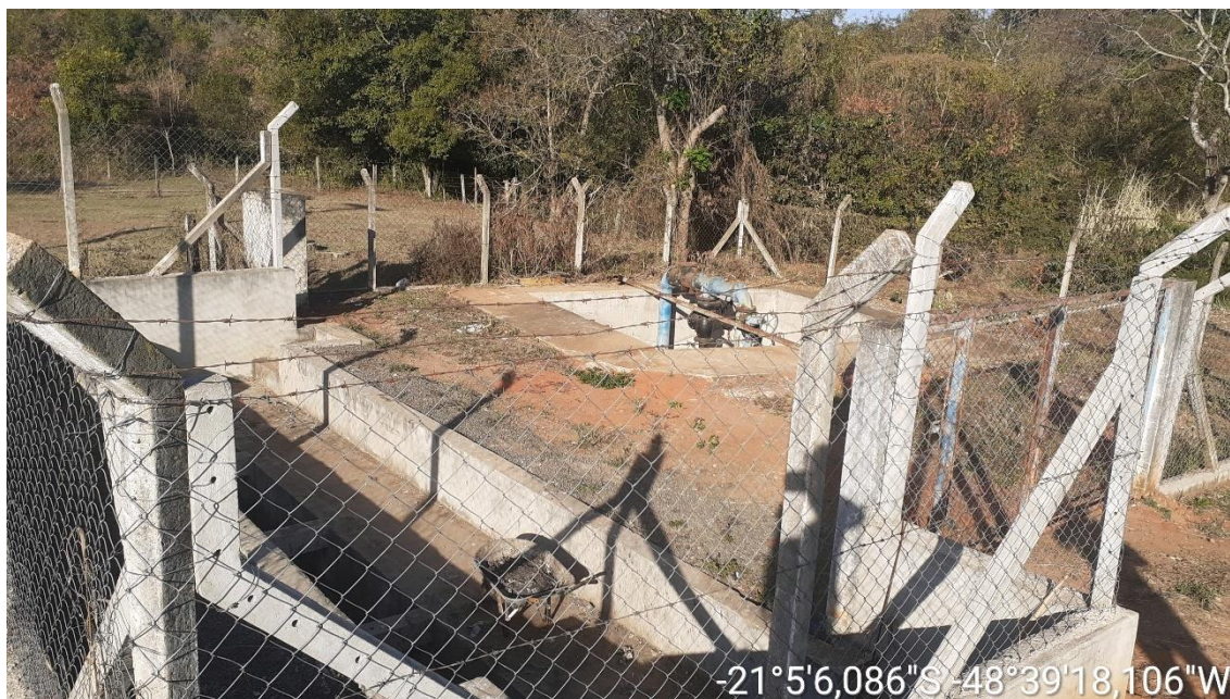
Figura 9-5. Aspectos da Estação Elevatória do Ginásio de Esportes.
