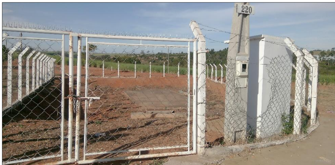
Figura 9-6. Aspectos da Estação Elevatória do Jd. Catharina Covielo
